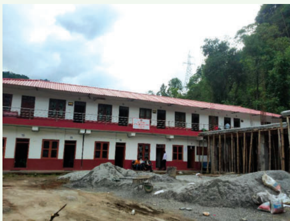
फोटो १८: निर्माणाधीन गापालिकाको कार्यालय
