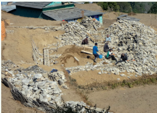
फोटो १३: मोदी गा.पा. ४, वयाङ्मा स्थानिय स्रोतसाधन प्रयोग गरेर निर्माण कार्यमा संलग्न तालुङ्का
